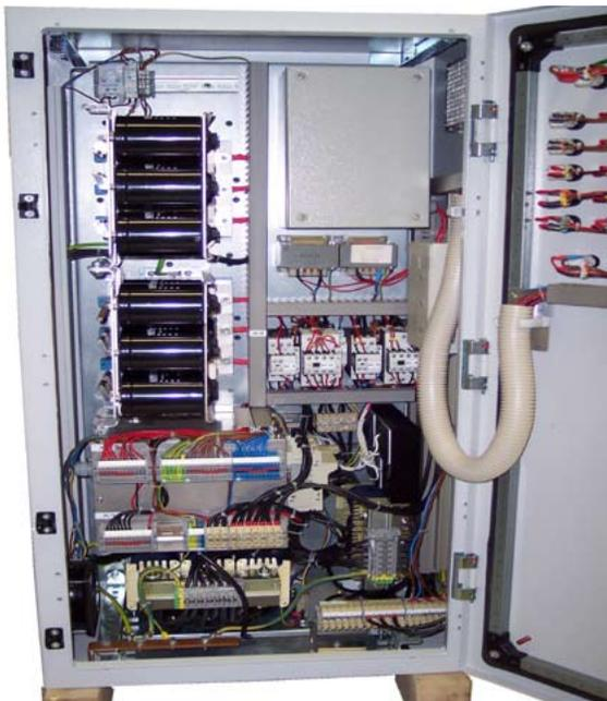
Abb. 1: Aufbau des Frequenzumrichters
